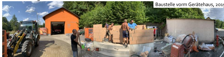
Baustelle vorm Gerätehaus, 2019
